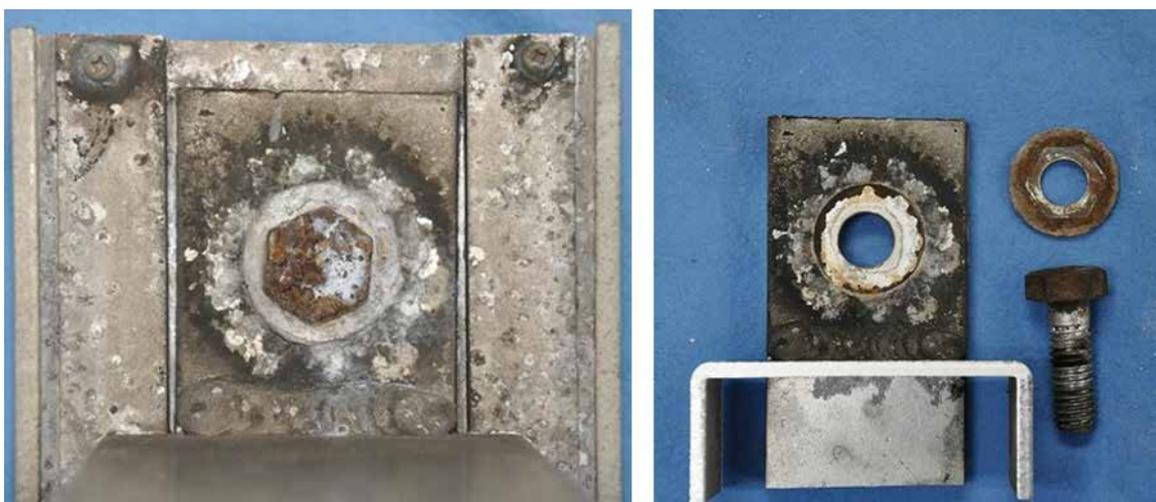
道路側に設置されている防護柵裏側。昭和41年施工で錆びてはいるが構造的に問題ない。
