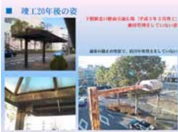
バスが接触して壊されたシェルター
