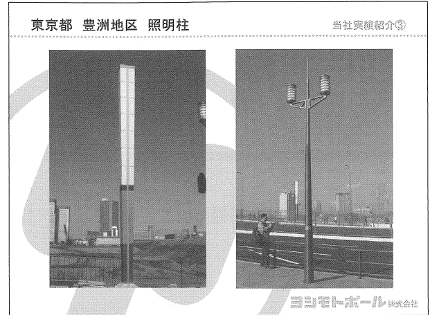
04 東京都 豊洲地区 照明柱
