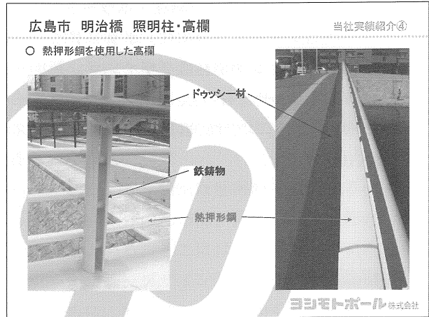
07 広島市 明治橋 照明柱・高欄
