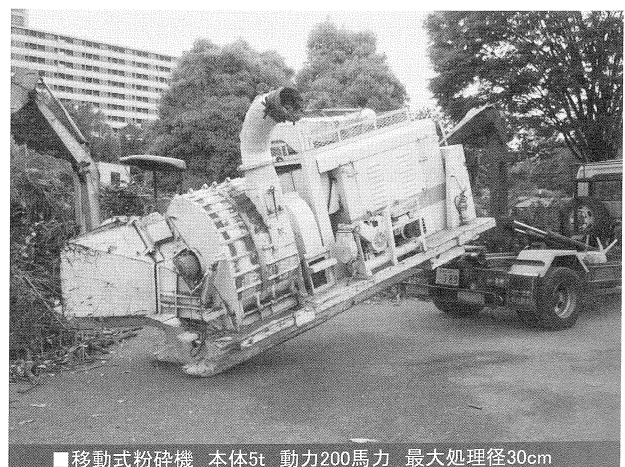
03 粉碎機の設置状況
