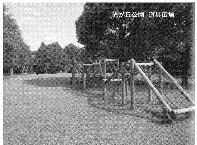
06 遊具周辺へのチップ材敷設
