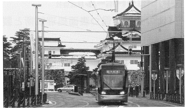
05. 富山都心線(大手モール架線柱 H=8m)
