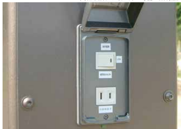
支柱下部の電源コンセント
