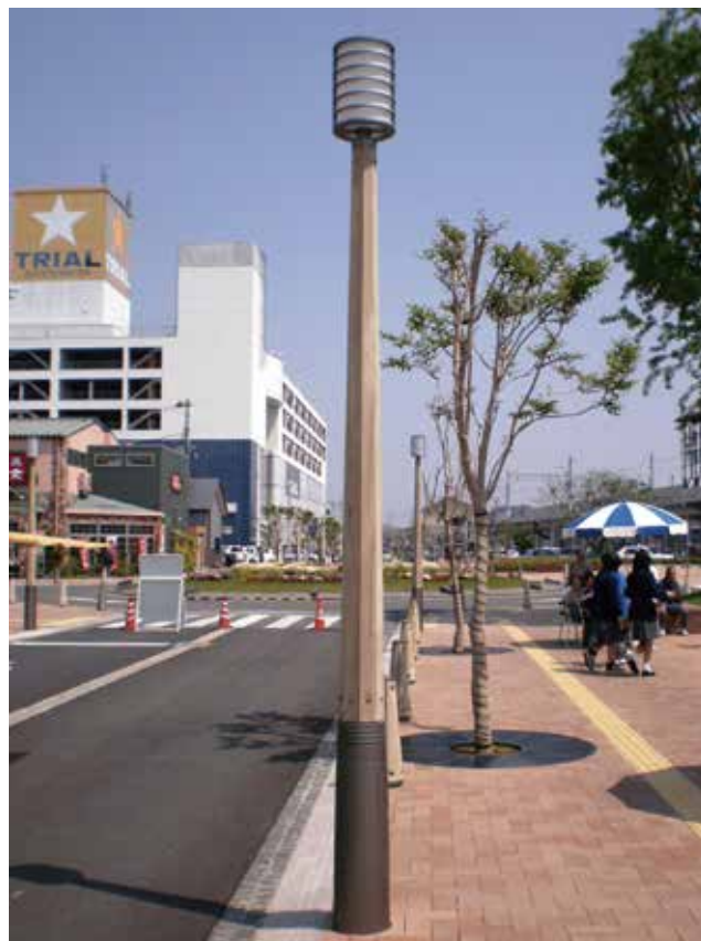
地場の飴肥杉を化粧材として使用した日向市照明柱
