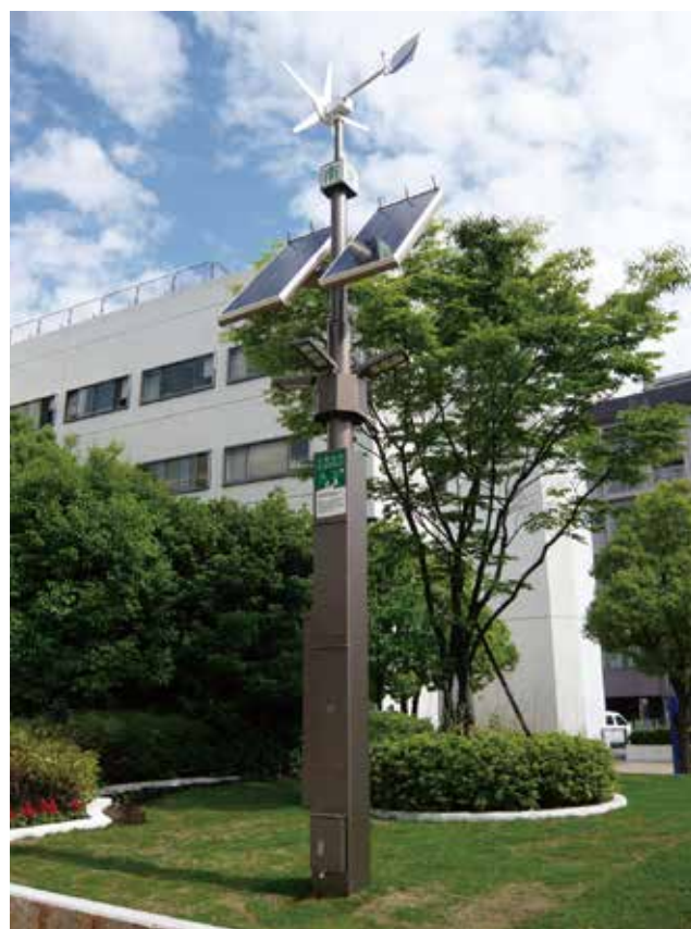
災害時支援照明柱 全景
