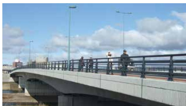
旭川市氷点橋 高欄兼用車両防護柵
