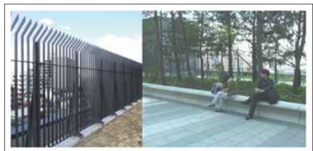
img-2. 設置されたフェンス
