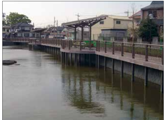
調整池遊歩道デッキ板
