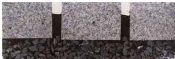
写真-3 インジェクト工法 断面
