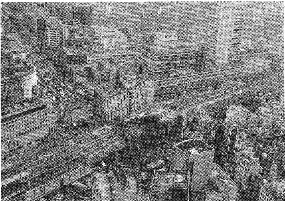
三宮の崩壊、多くのビルが中間階でつぶれている
