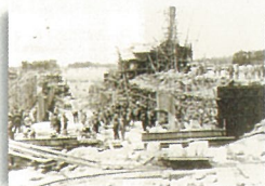
建設中の中島開門
