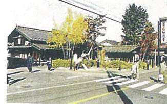
県道から見るゆう然楼周辺町並修景事業地区
