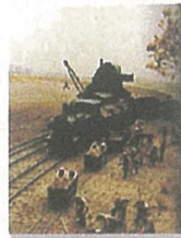
●荒川水路の建設工事風景
