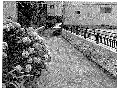
鞍月用水／用水上に歩道を整備
