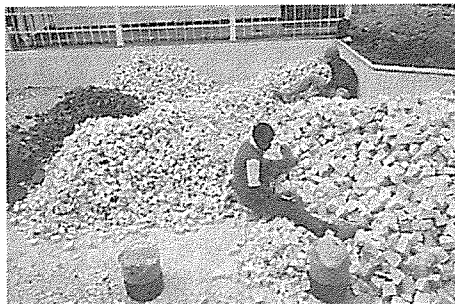
【写真5】敷詰工事
