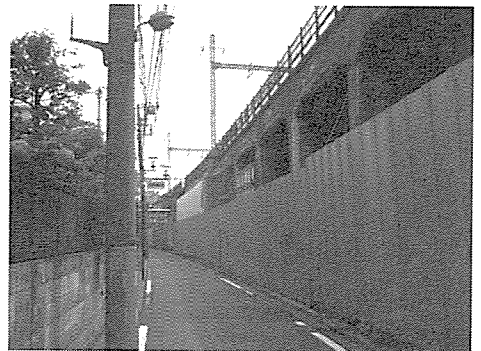
図-4 高架下の補強工事
