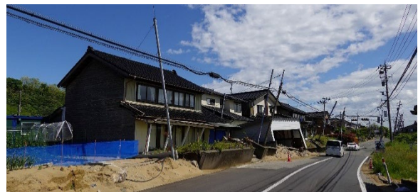
液状化で側方流動した家屋
