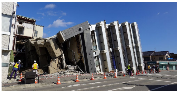
倒壊した7階建てのビル
