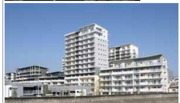
写真16：多様な南ファサード景観
