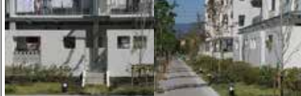
写真4、5：道路沿いにはアクセスの可能な専用庭を配し、住宅毎の個性と生活感の表出する安心安全で楽しいタウンスケープのまちなみ、空間を創出
