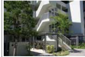
写真8：通路沿いに降りてくる屋外階段
