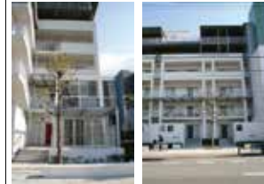
写真12：沿道にも面し出入り可能な集会所
