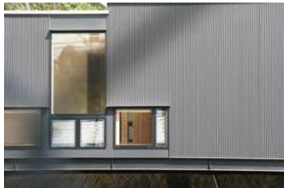
写真3：外壁と開口部のディテール
