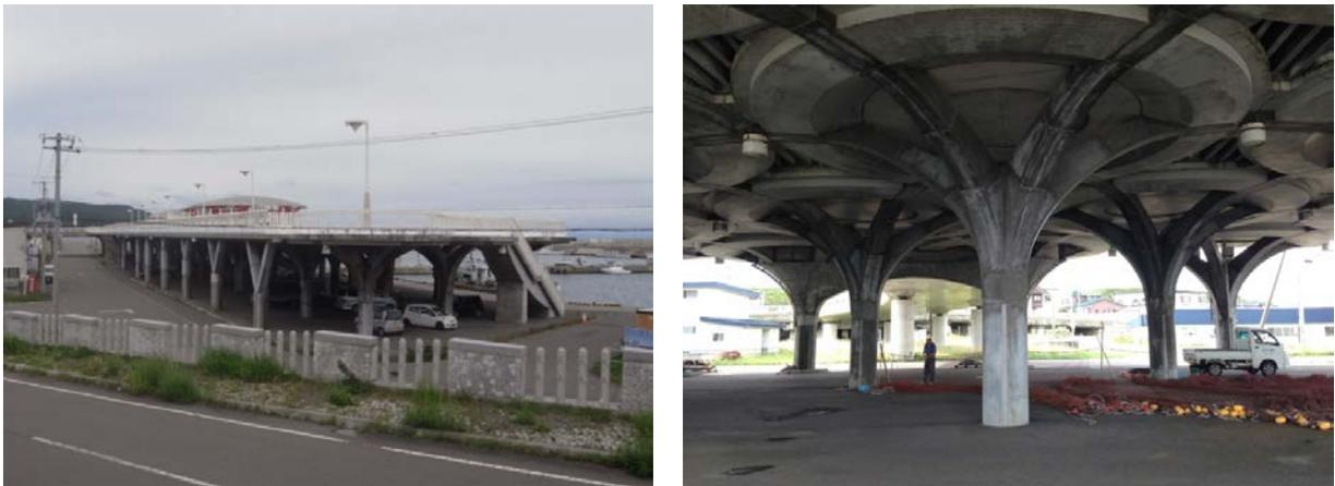
図 12 青苗漁港に整備された高架人工地盤
