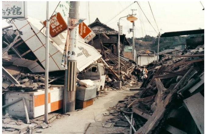
写真 1 倒壊した家屋が中道をふさいだ<sup>3)</sup>
