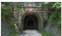
②三瓶隧道
