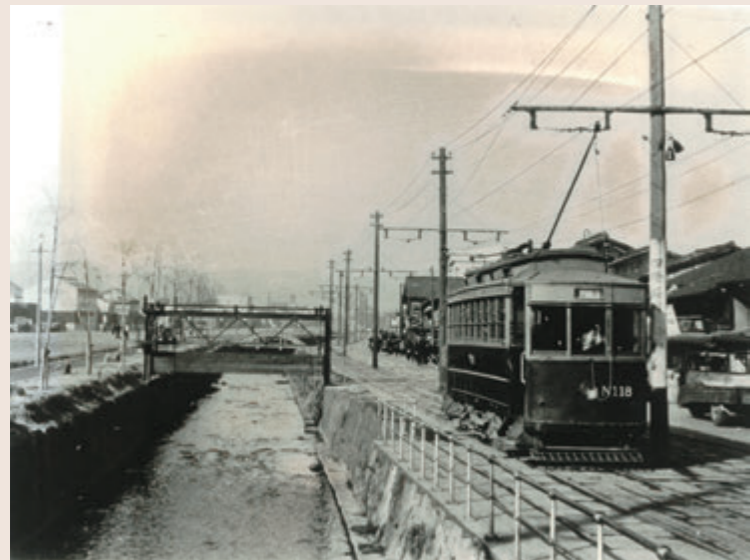
四条堀川の市電の停留所。堀川にかかるゲートのようなものは火災時に水をせき止め、放水用の水とした。
