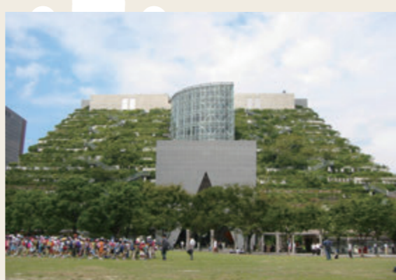
図2 階段状の屋上緑化 (アクロス福岡/福岡市)
