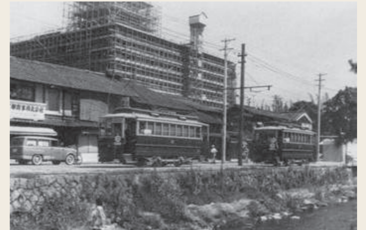
堀川二条を走る電車。京都国際ホテルが建設中（広報誌『なかぎょう』）
