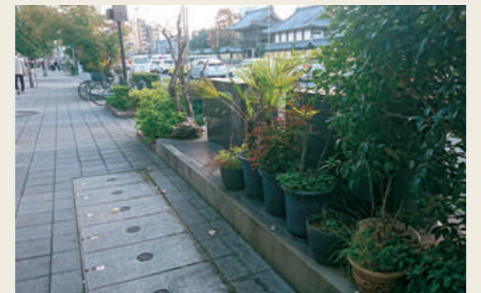
地上機器（電気設備）を隠すプランター植栽。
