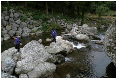
第 17 回「鏡川の多自然河川工法」高知県高知市
