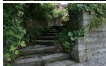
笏谷石の階段と石垣
