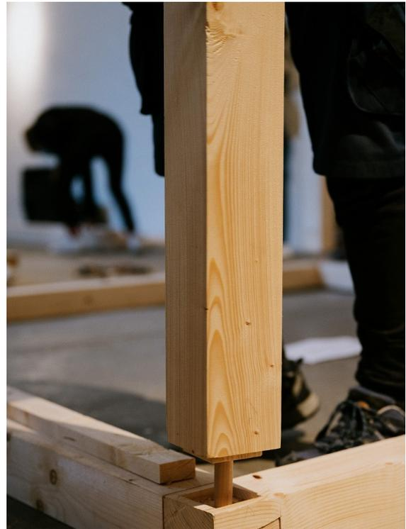
図-7 ベルリンUTSUWAプロトタイプ01の仕口
